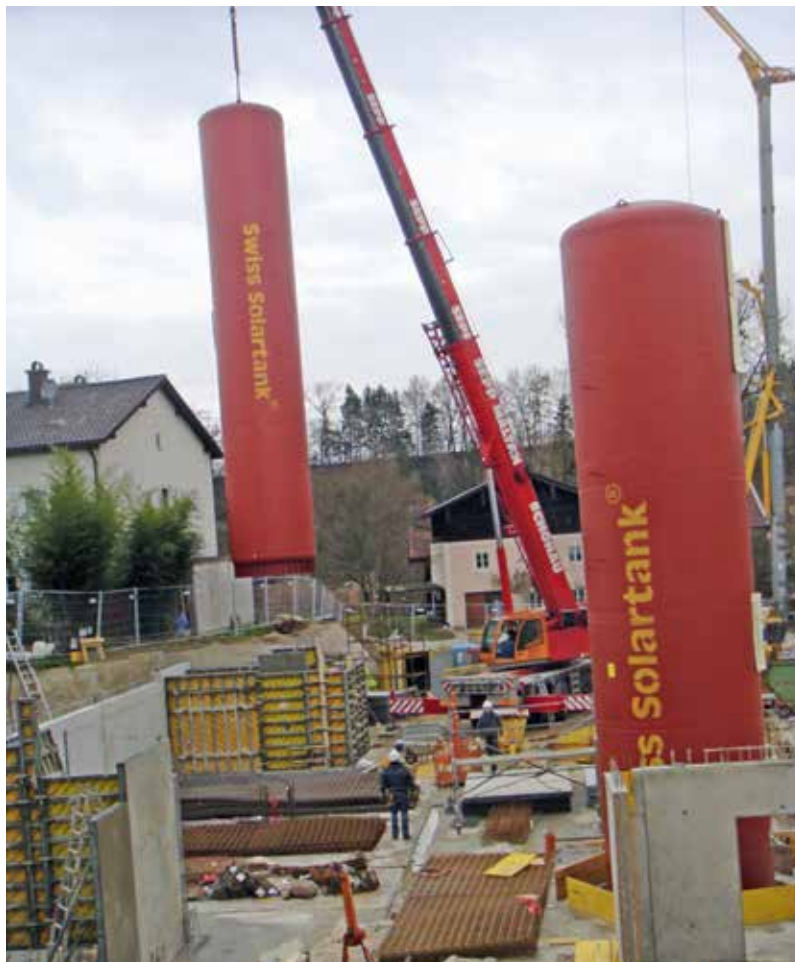
Kurz vor Weihnachten wurden zwei Solargroßspeicher von Jenni in Laufen in Oberbayern aufgestellt. Dort baut die gemeinnützige Baugenossenschaft Selbsthilfe Salzachkreis gerade neue Mehrfamilien-Sonnenhäuser. Anlagenkonzept und Kerntechnik stammen von Solar-Partner Süd.
